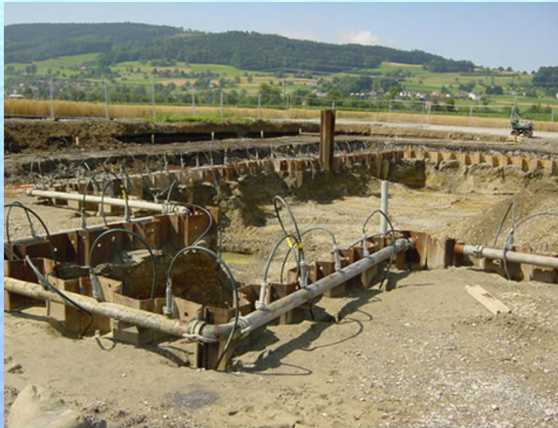
Beispiel einer Grundwasserabsenkungsanlage [5]
