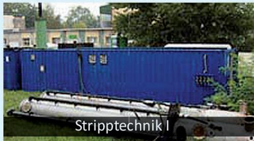
Mobile Strippanlage mit zwei Strippskolonnen, Pumpen, Verdichter und Speichertanks; installiert in zwei gedämmten Überseecontainern (20 und 40 Fuß)
